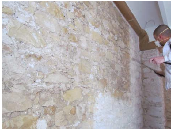
* Rehabilitación de pared envejecida.
