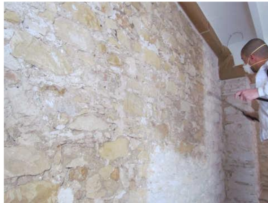
* Rehabilitación de pared envejecida.
